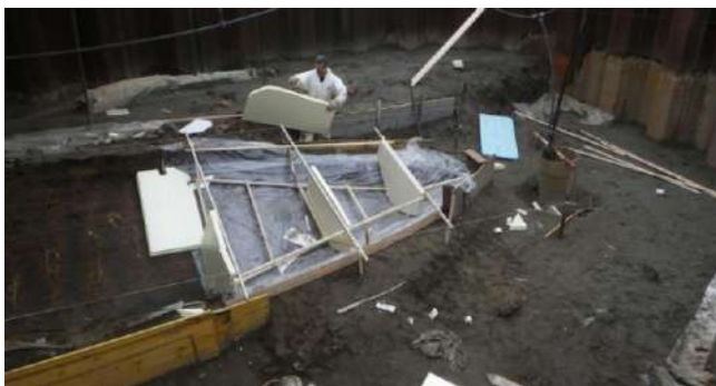
Figura 5. Costruzione del telaio per la controforma in poliuretano. Fase iniziale della realizzazione
