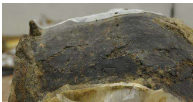
Figura 8 Particolare di un'area interessata da grave decoesione strutturale
