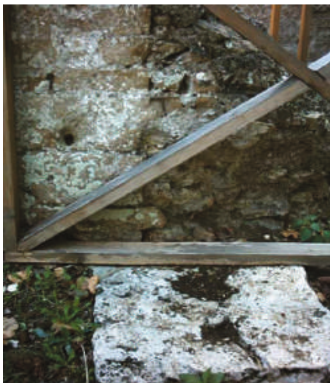
Figura 6. Particolare della mazzetta orientale dell'ingresso
