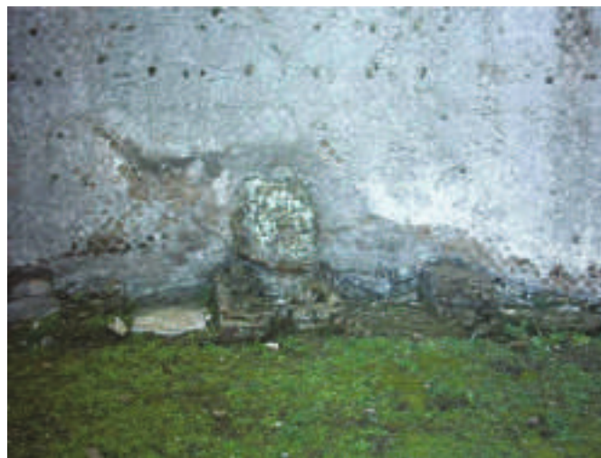
Figura 7. Particolare dell'esedra curvilinea occidentale
