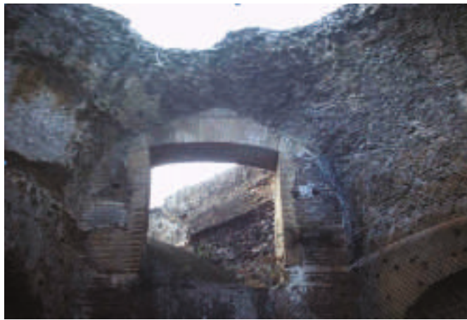
Figura 3. Sala ottagonale: particolare della copertura in corrispondenza dei lati rettilinei
