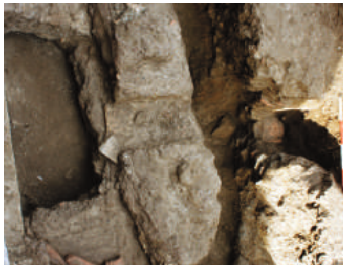
Figura 9. A partire da destra: alloggio per fistula e condotto di scarico che si riallaccia alla fognatura principale.
