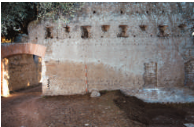
Figura 3. Parete meridionale della corte. Sono visibili gli alloggiamenti per una travatura che si interrompono in corrispondenza della porta situata nell'angolo Nord-orientale dell'ambiente. Si può notare inoltre la disposizione dei fori per incrostazione marmorea.
