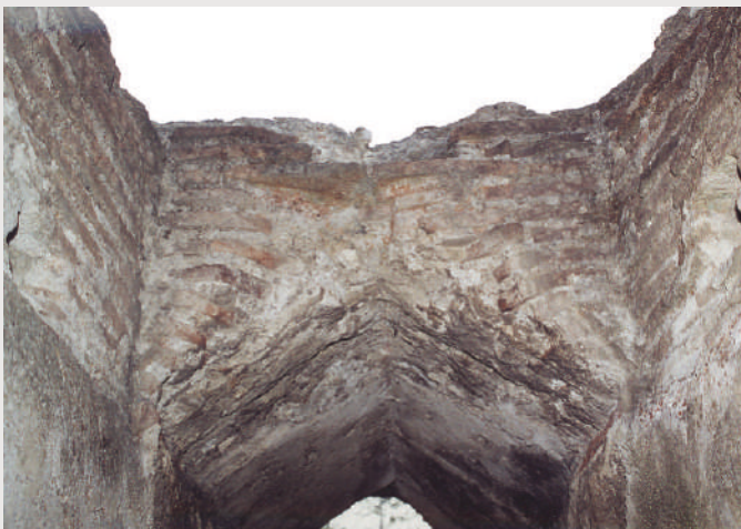
Figura 33 Palma Campania; speco in opera laterizia. Il pozzetto di ispezione.
