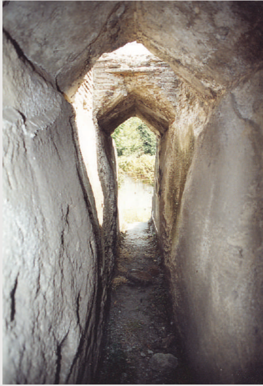
Figura 34 Palma Campania; interno dello speco in opera laterizia con le incrostazioni calcaree.
