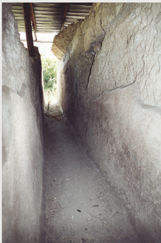
Figura 22 Palma Campania; parete Nord del canale in opera reticolata; i cubilia sono stati scalpellati per migliorare la tenuta tra contrafforte laterizio e parete retrostante.
