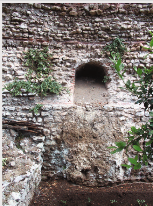
Figura 9 Mura d'Arce; il prolungato funzionamento del foro di scarico è documentato dalla quantità di tartari incrostati sulla faccia visibile della fondazione.
