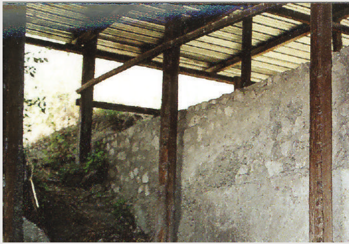
Figura 21 Palma Campania; l'intonaco originale è ancora conservato sulla parete Sud del canale in opera reticolata.
