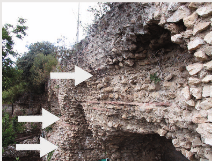
Figura 10 Mura d'Arce; le frecce bianche indicano i piani di scaglie in selce; non c'è alcuna corrispondenza tra questi ed i marcapiano in bipedali.
