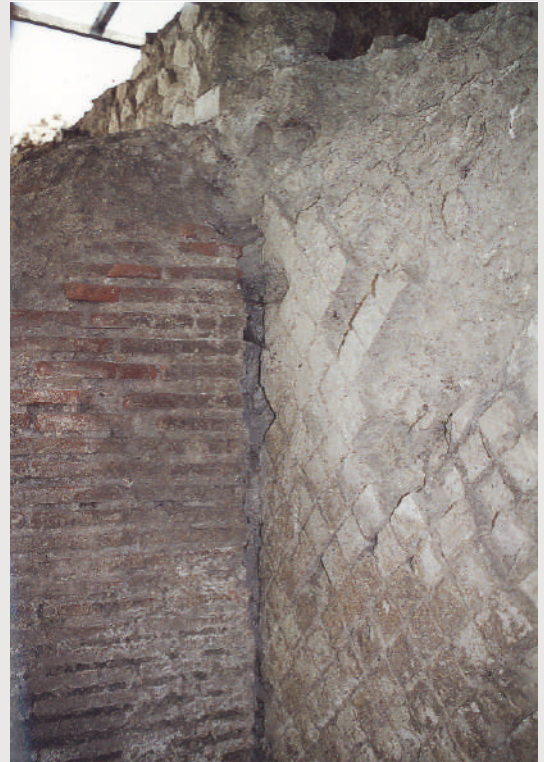
Figura 22 Palma Campania; parete Nord del canale in opera reticolata; i cubilia sono stati scalpellati per migliorare la tenuta tra contrafforte laterizio e parete retrostante.
