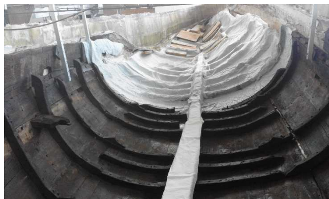
Fig. 9: Nave C, preparazione per la catalizzazione
