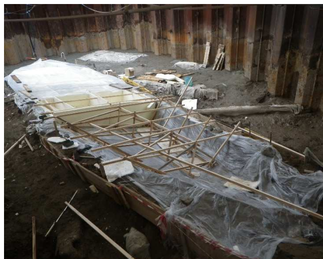
Fig. 3: Nave I, costruzione del supporto
