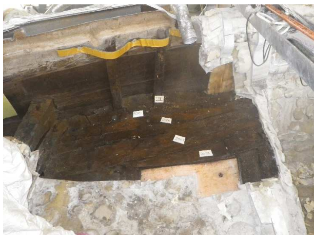
Fig. 4: Nave C, smontaggio VTR ponte di prua
